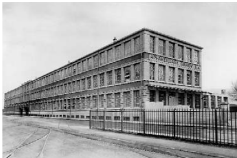
L'usine "du vélodrome", vue depuis l'avenue de la Jonction, 1919 (BPU). Longue de 130 m, elle est construite en 1918-19 sur l'emplacement de l'ancien vélodrome.
